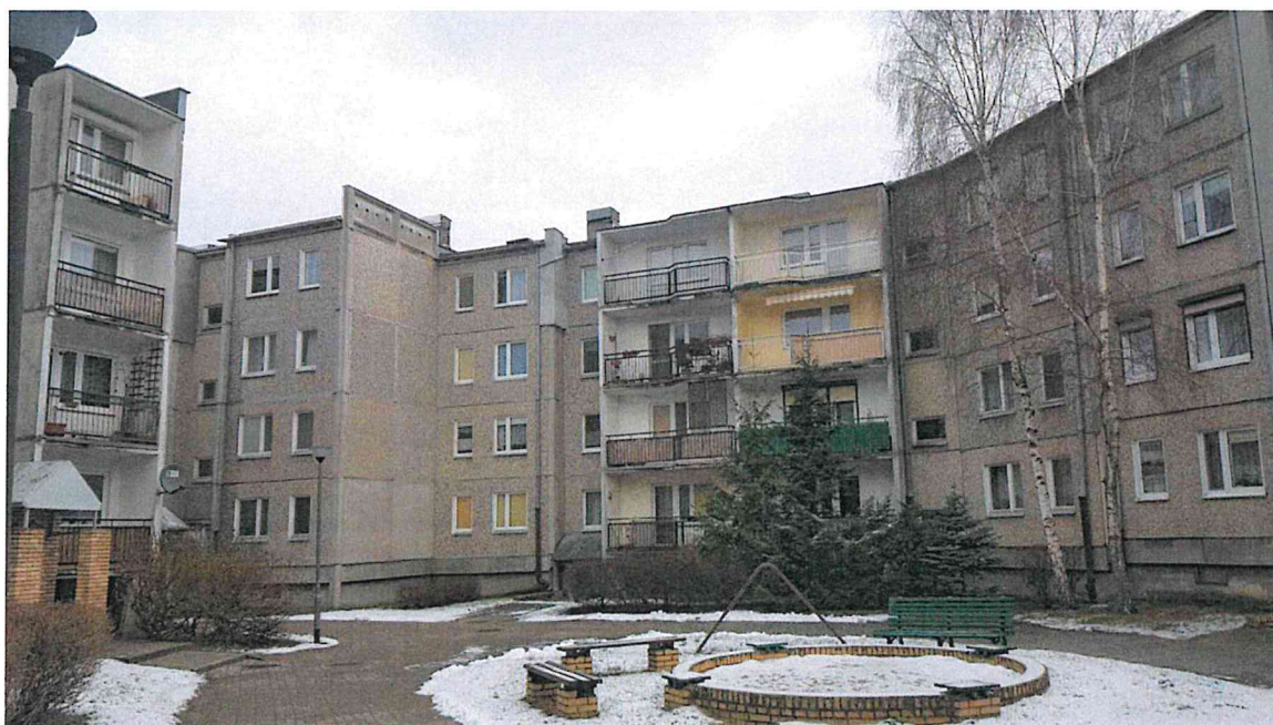
Fot. 2 Elewacja zachodnia
